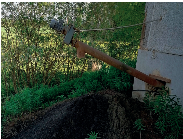
Puutteellinen tuhkanpoisto lisää palovaaraa tuulen ja kipinöiden yhteisvaikutuksesta (Kuva: EP-pelastuslaitos palontutkinta)
